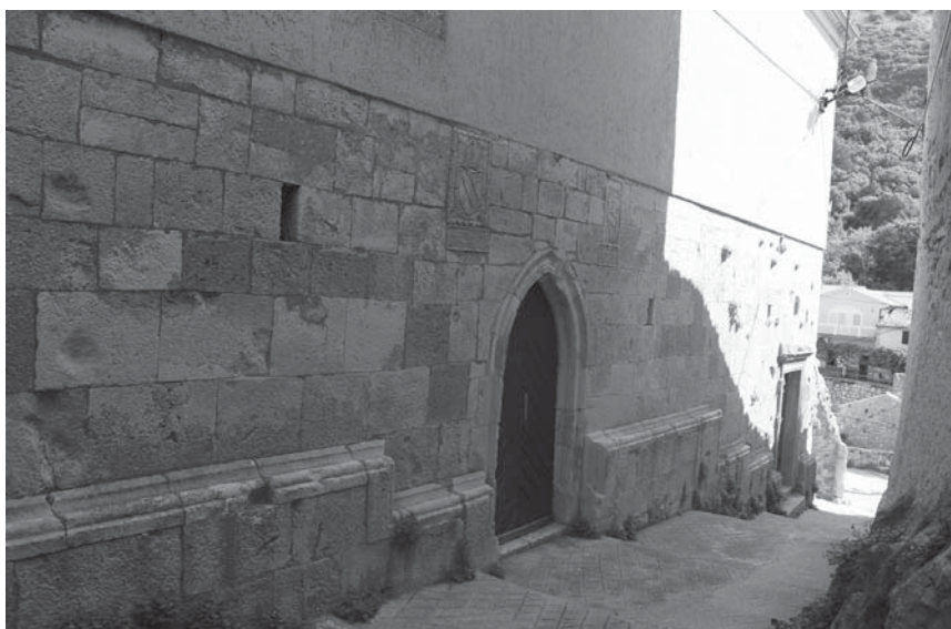
Sl. 2. Plomin, župna crkva, jugoistočni zid
