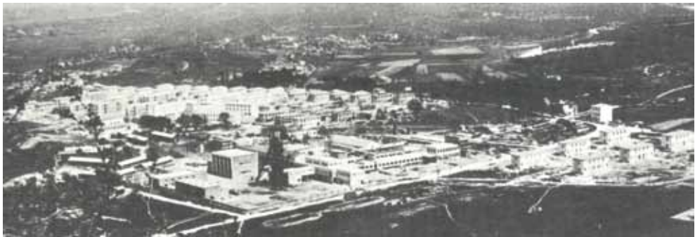
Sl. 5. Pogled na gradnju Podlabina (arhiva udruge Atrium)
